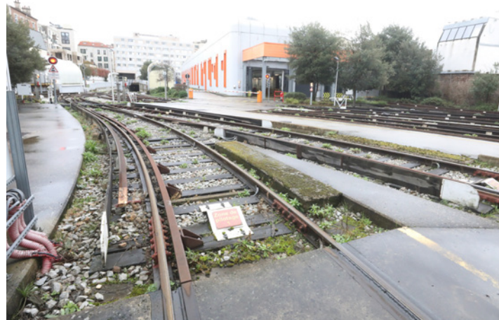
■ Les rails devant le centre de maintenance. À droite, l'atelier où sont changés les bogies.
